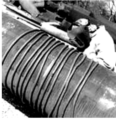
Hình 5: Giải pháp khắc phục thổi lệch từ khi hàn ống
